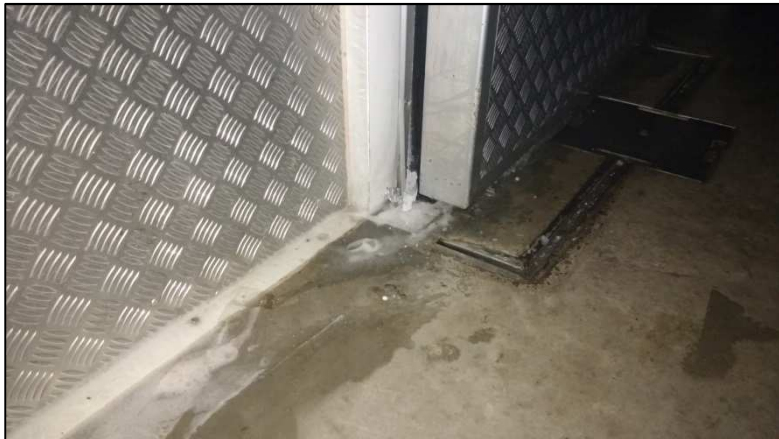
Figura 2 - Formação de gelo nas soleiras da porta – Porta fechada.
