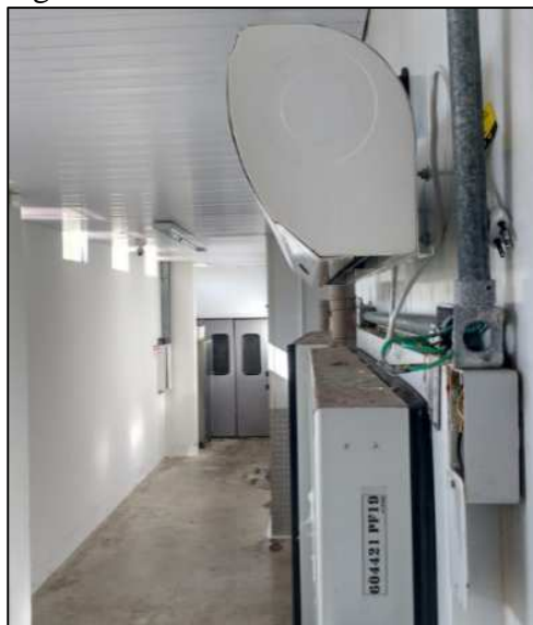
Figura 10 - Vista lateral da cortina de ar instalada.
