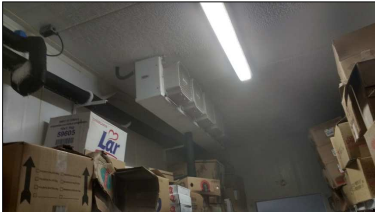
Figura 4 - Um dos dois evaporadores instalados na câmara.
