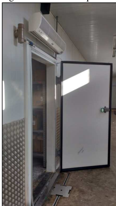
Figura 13 - Válvula equalizadora de pressão, canto esquerdo superior.
