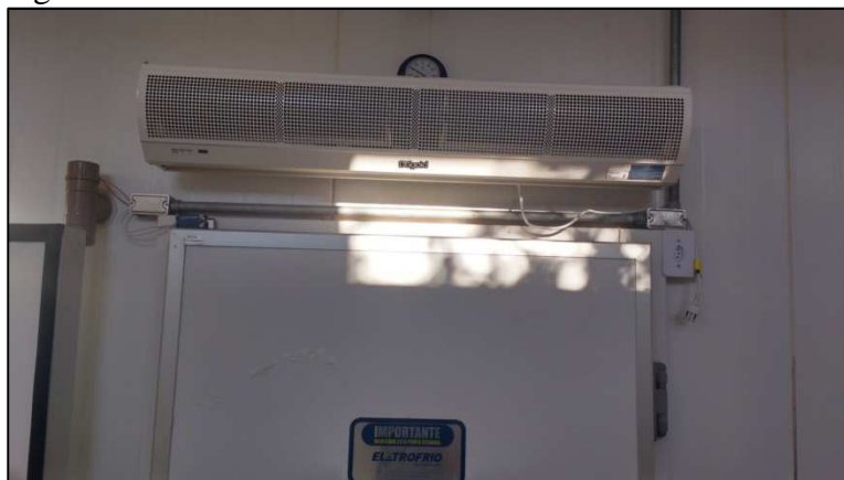
Figura 9 - Cortina de ar instalada.
