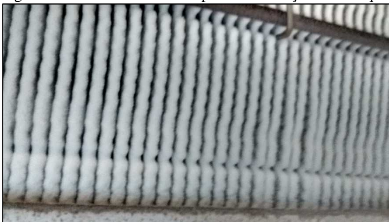
Figura 5 - Entrada de ar do evaporador começando a bloquear.
